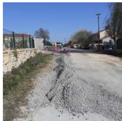
Rue des Carons à Crêches-sur-Saône Mise en séparatif par la pose d'un réseau pluvial
