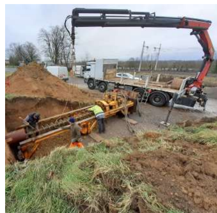
Fonçage sous Route Départementale pour extension, à Sennecé-lès-Mâcon
