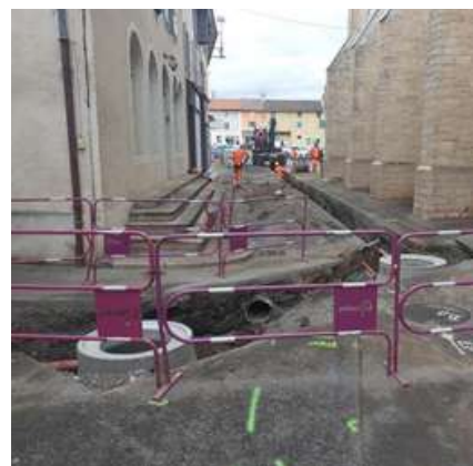
Rue des Carons à Romanèche-Thorins Mise en séparatif par la pose d'un réseau Eaux Usées
