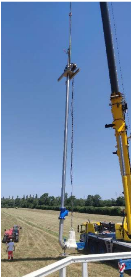
Changement de la colonne de refoulement et de la pompe du puits n°13 - Nettoyage des barbacanes
