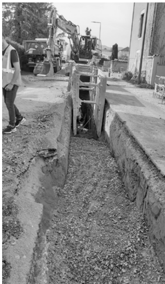
Chantier d'assainissement de route du Port d'Arciat à Crêches-sur-Saône
