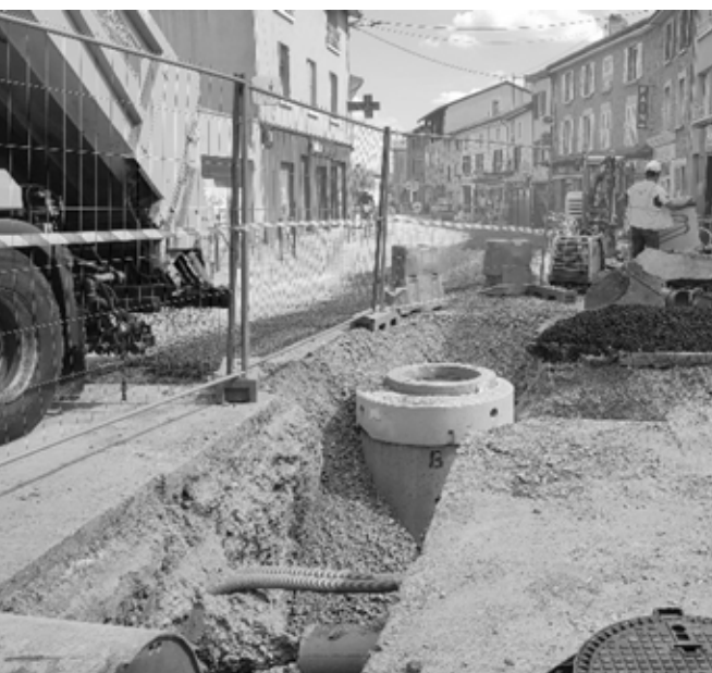
Chantier de la rue de la Liberté à Mâcon
